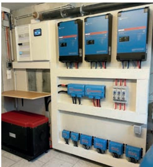
Victron ESS-System mit Cegasa Speicher
