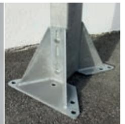
Montagekonsole für Stahlstütze-Freilandsystem
